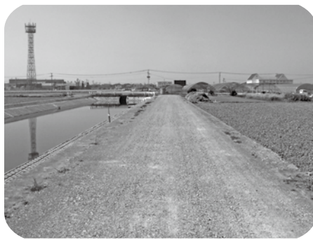
舗装工事予定地(兼木地区)
