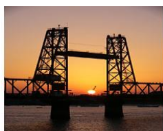
筑後川昇開橋 (国指定重要文化財)
