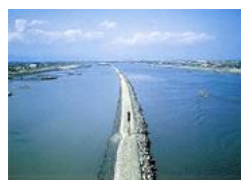
導流堤 (土木遺産認定)
